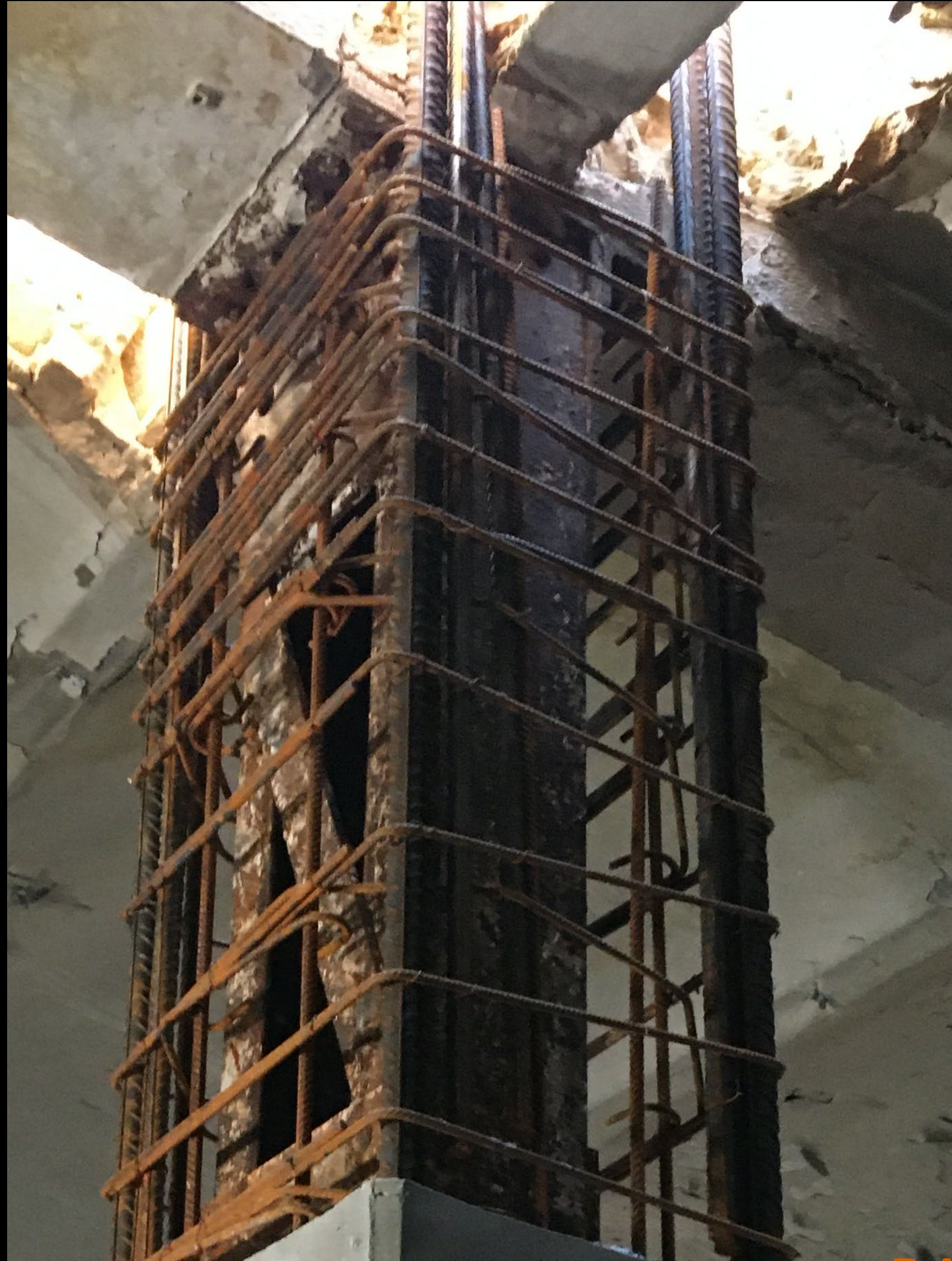
ERTÜCHTIGUNG VORHANDENER STAHLSTÜTZEN
