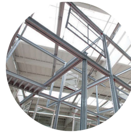
Stahlkonstruktion Laubengang
