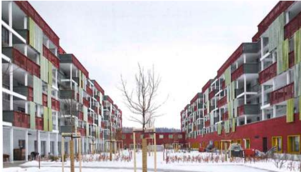
Innenhof der Giesserei in Winterthur_Foto Hannes Henz_TEC 21 9/2013
