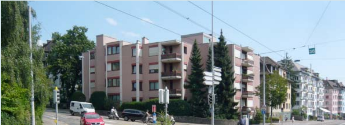
Zustand vor der Sanierung
