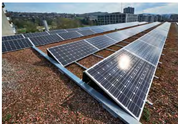
Solarstrom vom Dach für ...
